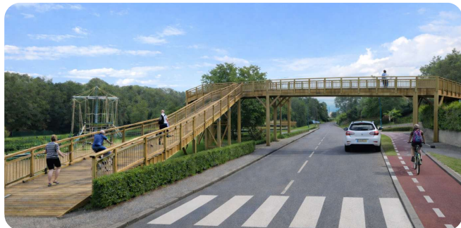
Passerelle rue Waltenhofen
